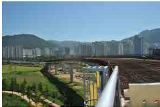
<그림 5-44> 대동화명대교 진입도로 공사
