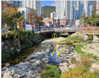
그림 7. 우동천 우안 하수 월류 상황 및 연도별 우동천 수질변화
